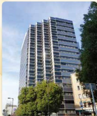
大阪本社 (堺筋本町センタービル4F)
